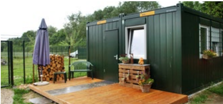
Die neue Katzenstation bekam eine Holzterrasse und einen gut begehbaren Zugang. Mit entsprechender Deko ist der Container mittlerweile sehr schön integriert.
